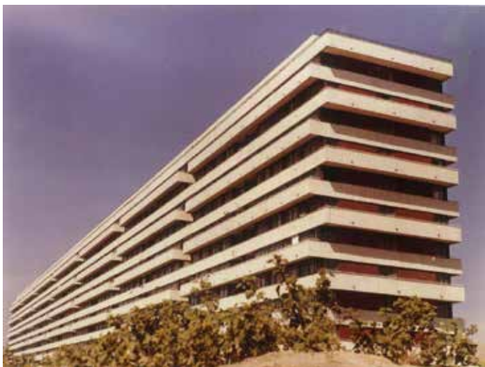
Slika 7. Stanovanjski blok »B-9« v stavbnem otoku 21 (1960–1966) Vir: zasebni arhiv avtorja prispevka
